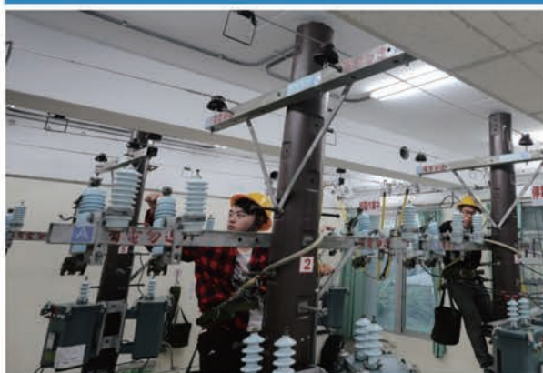
室內配線技能檢定考場
