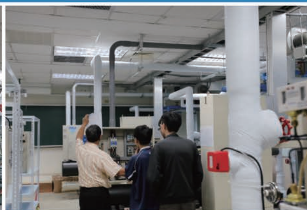
冷凍空調裝修技能檢定考場
